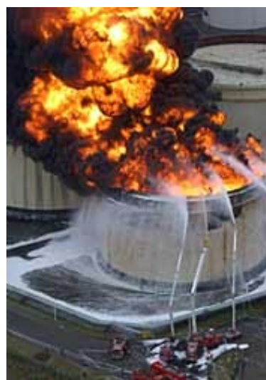
図1 十勝沖地震で石油タンク炎上
