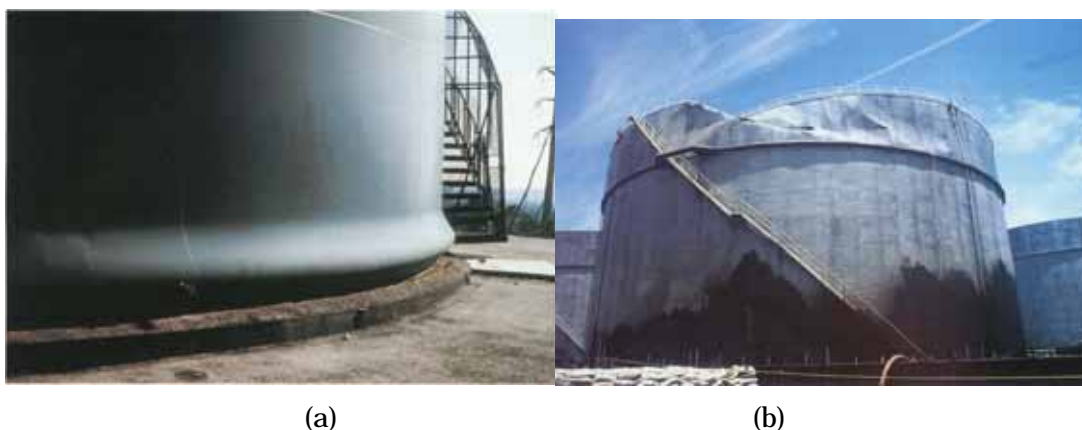
図 1 薄肉円筒殻の座屈による損傷 (文献6)
